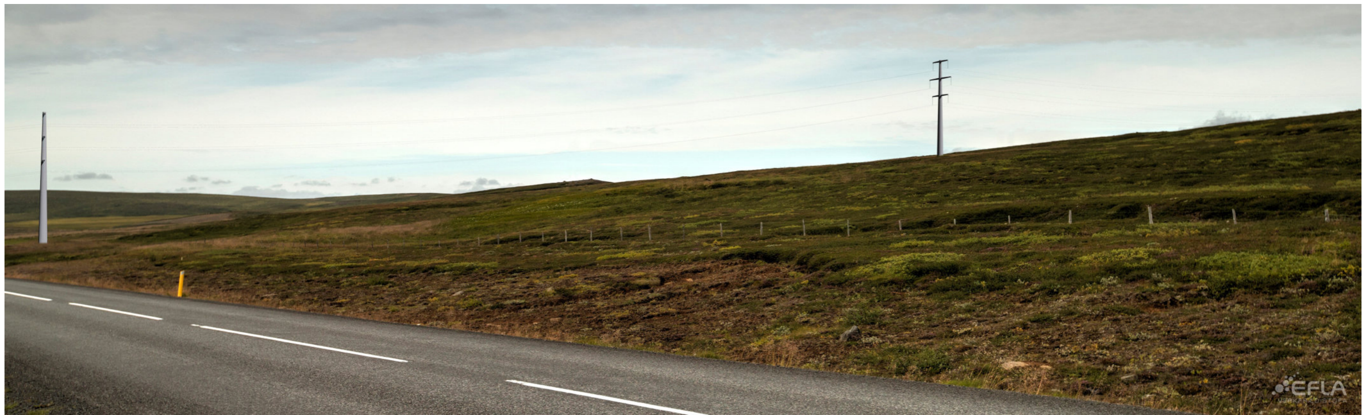
MYND RL-4.4 Frá þjóðvegi 1 í Reykjadal, horft í norður yfir þverun þjóðvegjar. Tvírása mastur með lóðréttri uppröðun, l-röramastur
