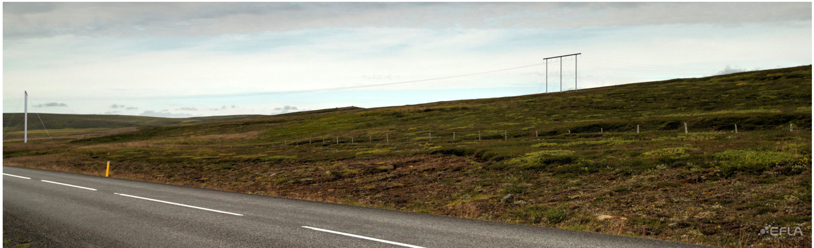
MYND RL-4.3 Frá þjóðvegi 1 í Reykjadal, horft í norður yfir þverun þjóðvegjar. Tvírása mastur með láréttri uppröðun, röramastur
