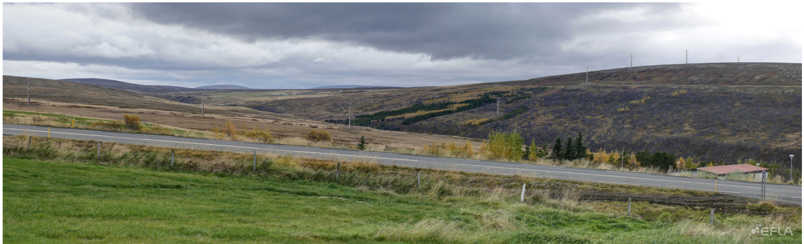
MYND RL-5.4 Frá Brún í Reykjadal, horft í suður yfir Reykjadalinn. Tvírása mastur með lóðréttri uppröðun, l-röramastur
